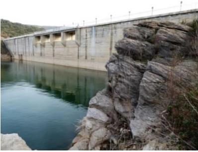
Para proyectar cualquier pantano, es necesario el trabajo de geólogos. Su labor consiste en reconocer la geología de la zona, haciendo prospecciones, mapas y cortes geológicos detallados, así como pruebas de resistencia y permeabilidad para verificar que el sustrato geológico es adecuado para asegurar la estabilidad de la presa y evitar fugas de agua.
